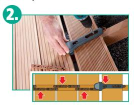
Apoye la tarima con la cara trasera vuelta hacia arriba a la tarima precedente y enrásela con el extremo superior de la misma. Coloque la plantilla de taladrar y alíneela perpendicularmente a la tarima, apoyándola por medio de dos las lengüetas de tope (flechas en la figura 1) según necesidad a la izquierda o derecha al ensamble precedente.
