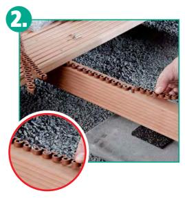
En caso necesario, los **listones distanciadores** pueden engancharse por sus extremos o acortarse. Las tarimas son atornilladas luego exactamente centradas sobre la viga. Así se asegura que la viga no pueda ladearse.
