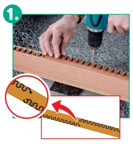
Atornille primero los **listones distanciadore** a las vigas de soporte. Los listones deberían atornillarse de forma no alineada una vez al borde izquierdo y a continuación al borde derecho de la viga.
