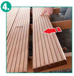
La parte sobresaliente delantera del ensamble se corre sencillamente por debajo de la tarima precedente. De este modo, la tarima se fija automáticamente al canto delantero y sólo tiene que sujetarse aún con dos tornillos en el canto trasero. Los ensambles sirven aquí al mismo tiempo de distanciadores entre tarima y viga de soporte, evitando así la acumulación de humedad capaz de acelerar la putrefacción de la madera.
