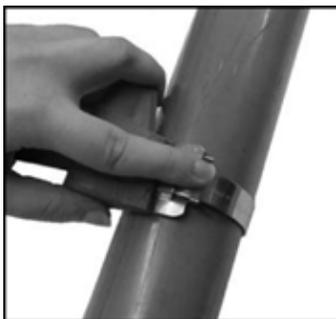
4. Coloque su dedo en la cinta BAND-IT en el Puente de la hebilla cuando este tensionando. En el momento que usted observe que la cinta detiene su movimiento hacia la hebilla se ha aplicado la máxima presión alrededor del elemento de trabajo. Detenga el giro de la manija de tensión.
